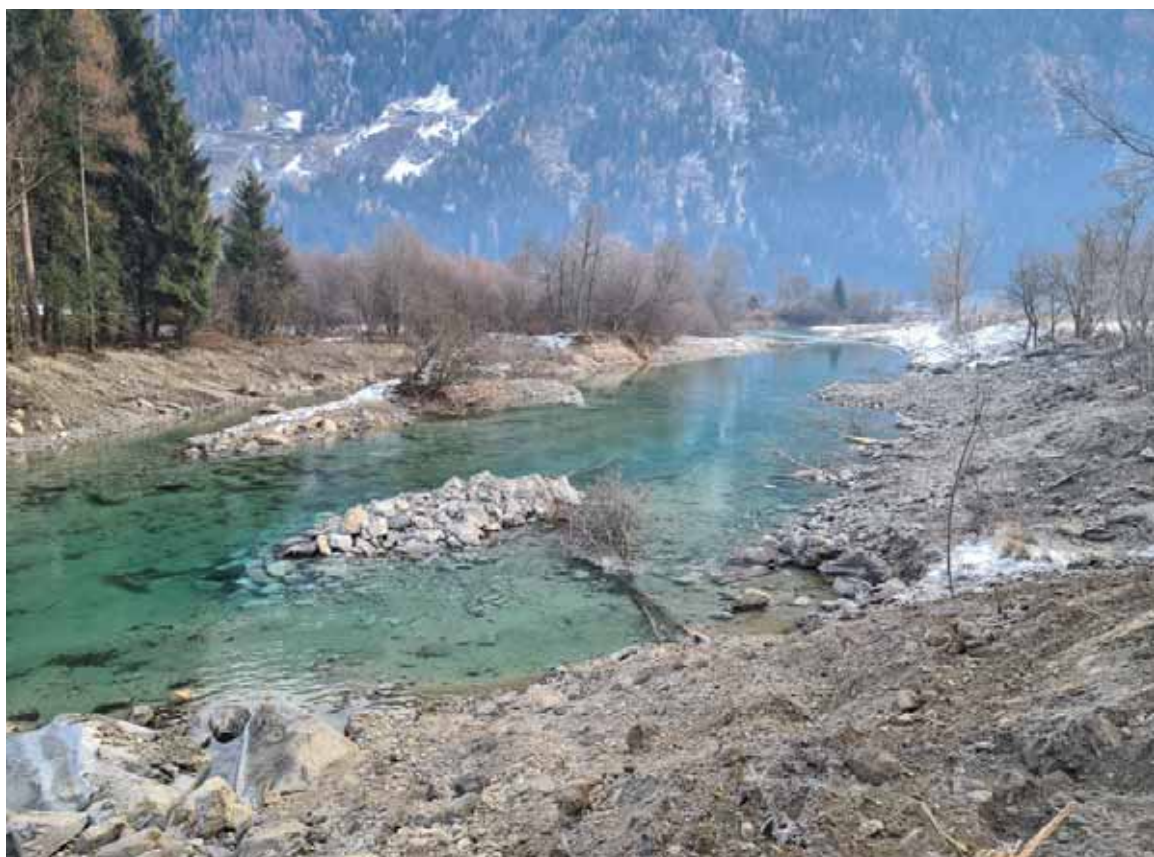
Naturnah strukturierter Abschnitt der Unteren Ahr flussabwärts der Gewerbezone Mühlen nach Umsetzung der Sofortmaßnahme zur Reparatur der unterspülten Uferschutzbauten im Dezember 2024.
